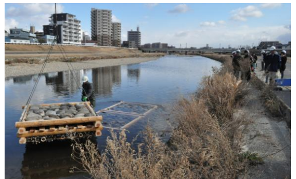
矢田川で行った「粗朶沈床工」の再現実験
