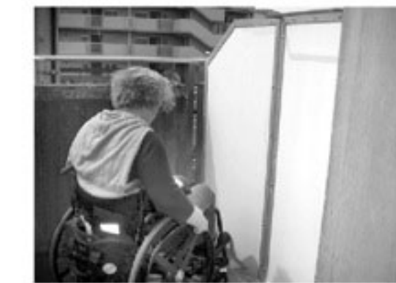
左：サマリアハウス全貌 右上：2階から見たスロープ 右下：1階から見たスロープ 左下：隣の部屋へはパーティションを車椅子で破って行く
